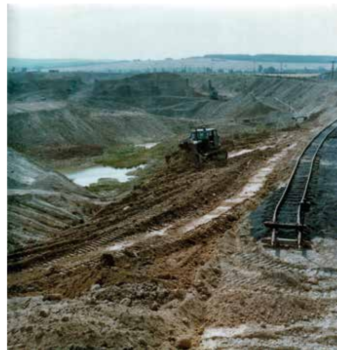
Abb. 5: Historische Aufnahmen aus dem Tagebau Callenberg-Nord I: (a) Blick Richtung Osten zur Reichenbacher Höhe.
